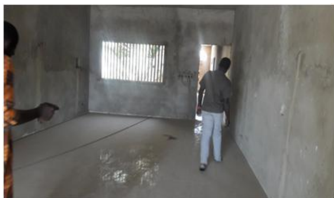
Photo 5. Le restaurant en chantier vue de l'intérieur. Cliché ADEPA, janvier 2018.
