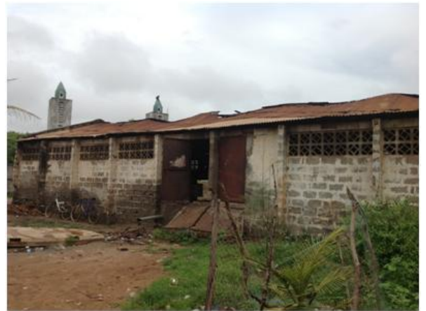
Photo 10. Hangar à réhabiliter dans le cadre de l'action collective de Brufut. Cliché ADEPA, août 2017.
